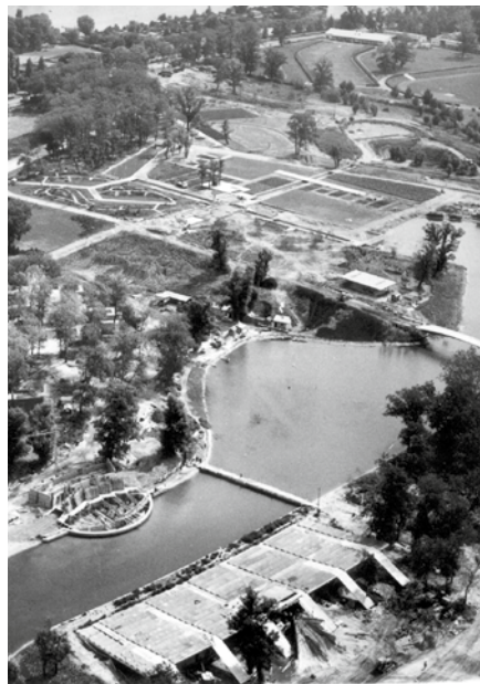
Irissee in der Bauphase Fotos: vga.at
